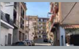
Rehabilitació integral del carrer Clausell
