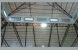
Rehabilitació de la coberta de la Plaça Mercat
