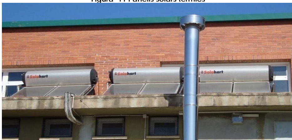
Figura 11 Panells solars tèrmics
