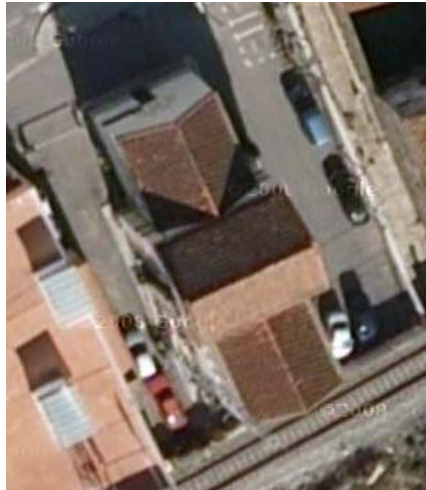
Figura 12. Coberta de l'edifici
