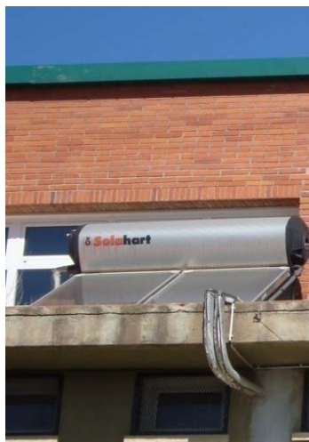
Figura 8 Panells solars tèrmics
