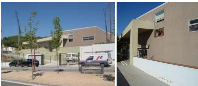
Figura 1. Vista del edifici
