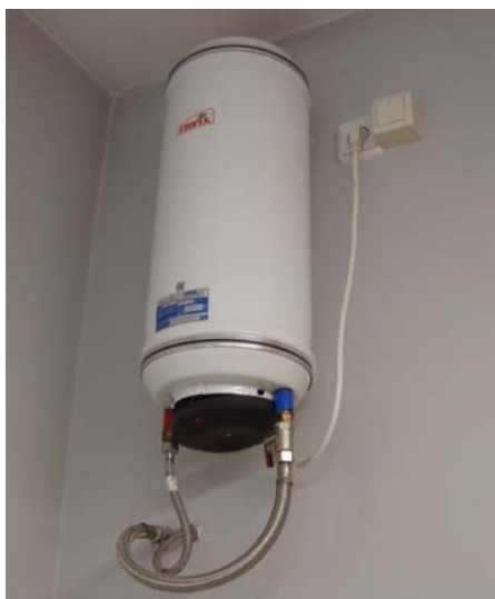
Figura 5 Escalfador elèctric
