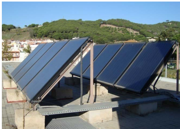
Figura 11. Panells solars tèrmics
