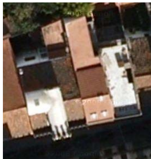
Figura 5. Coberta de l'edifici
