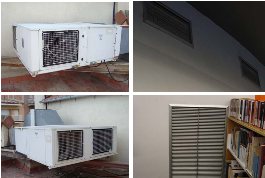
Figura 6 Bombes de calor
