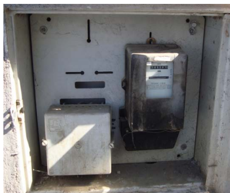
Figura 2. Comptador elèctric
