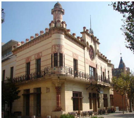
Figura 1 Vista del edifici
