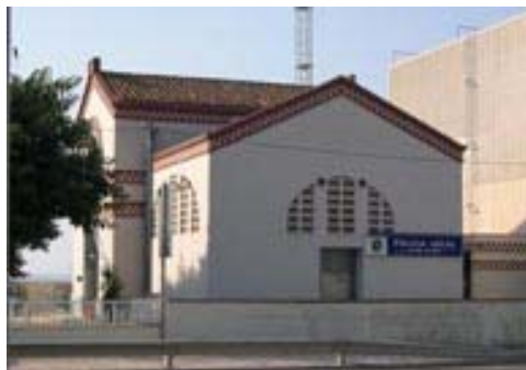
Figura 1. Vista del edifici
