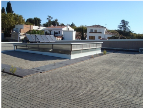
Figura 10. Coberta de l'edifici
