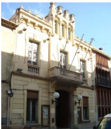
Figura 1. Vista del edifici
