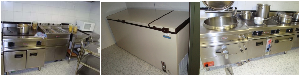
Figura 7. Equipaments de la cuina
