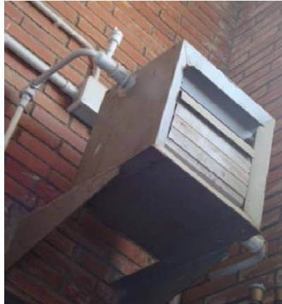
Figura 7 Aerotermos gimnàs
