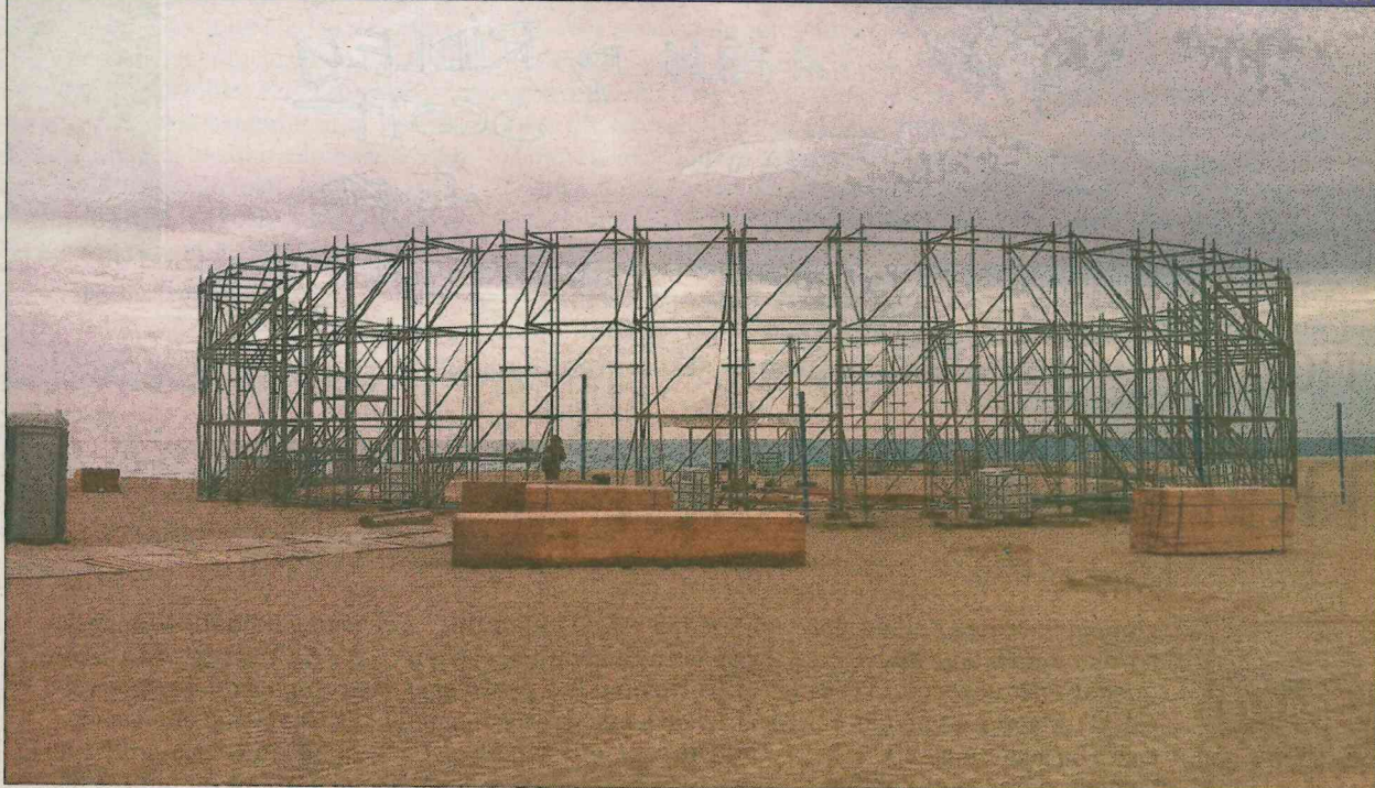
L'estructura que s'està muntant a la platja del Cavaió per rodar-hi els exteriors de Sinera ■ E.F.
