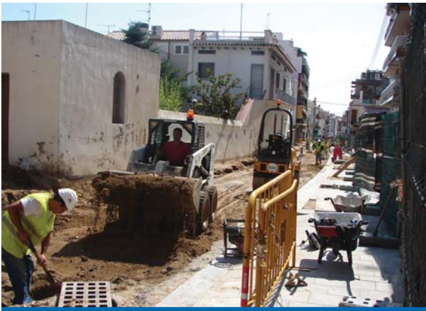
Les obres al juny de 2009
